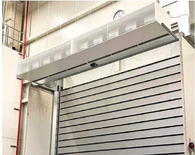
Windbox L,XL Meervoudige installatie van Industriële luchtgordijnen in een fabriek
