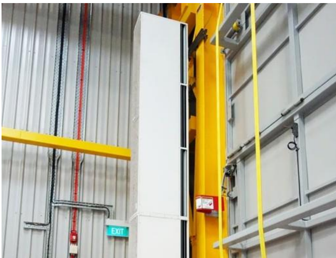
Windbox L,XL Meerdere modulaire torens op een grote hangardeur
